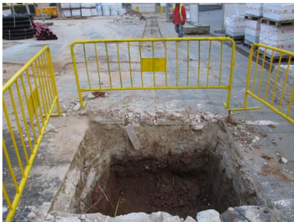
13. Vista general de l'arqueta 5
