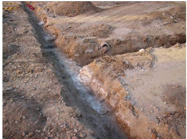
26. Mur UE 13 a la rasa 2
