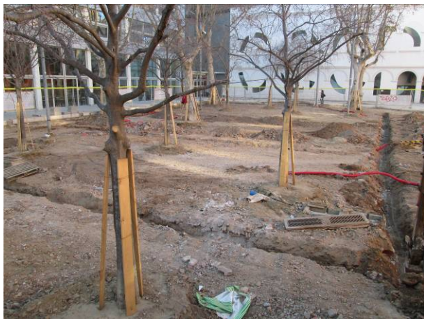
19. Vista general de les rases de drenatge
