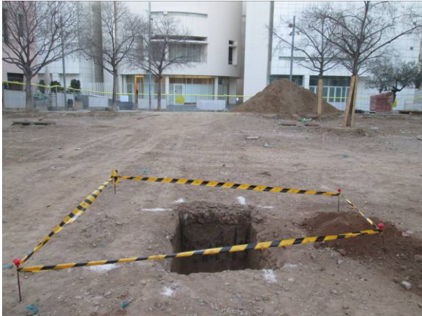
9. Vista general de l'arqueta 3
