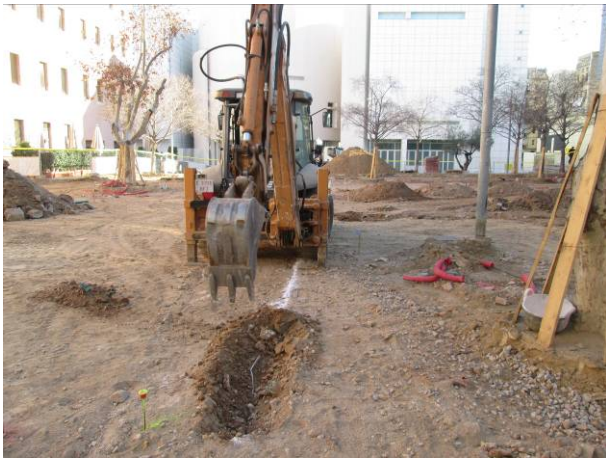
25. Inici excavació rasa 2
