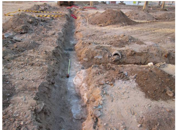
28. Mur UE 13 a la rasa 2
