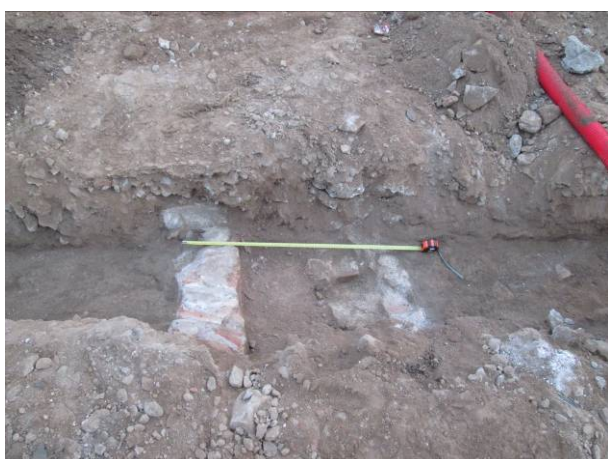
17. Claveguera UE 15 a la rasa de l'enllumenat
