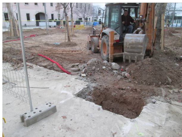
6. Excavació de l'arqueta 1
