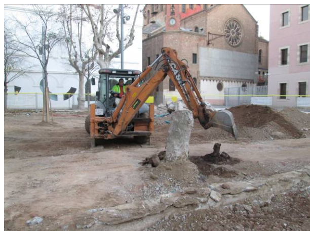
4. Retirada de la soca al centre de la plaça
